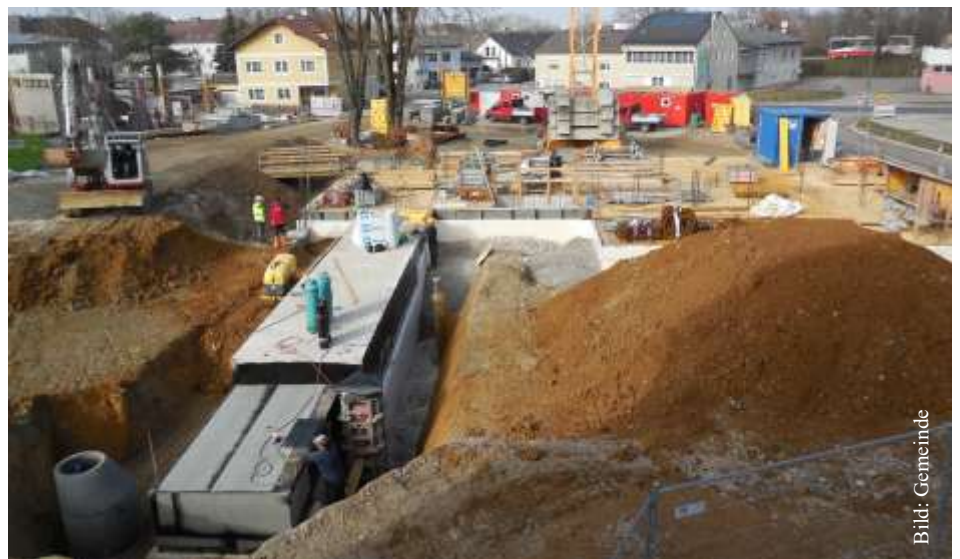
Der aktuelle Blick auf die Großbaustelle am 22. Februar 2021 vom Balkon des alten Gemeindeamtes
