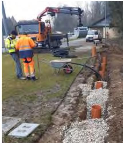
Die restlichen Arbeiten (Drainageschlauch verlegen, PVC-Hülsen für Zaun setzen, Rollierschotter einbringen,...) stemmte der Bauhof mit fleißigen Helfern des Sportvereins.
