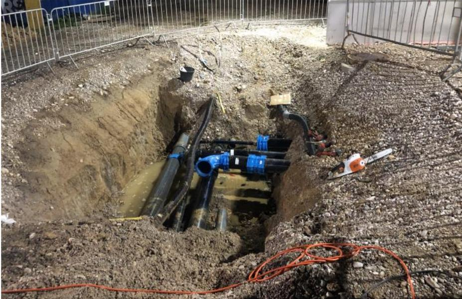
Umschluss der Wasserleitungen vom Wasserturm zum Tiefbehälter.
