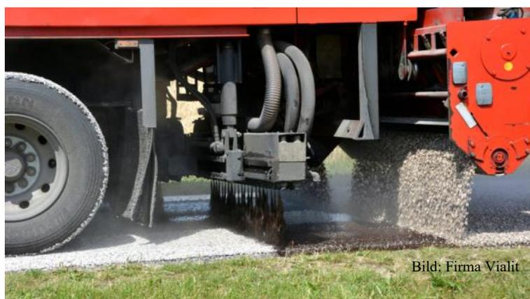
Detailaufnahme vom Auftragen von Bitumen und Kies.
